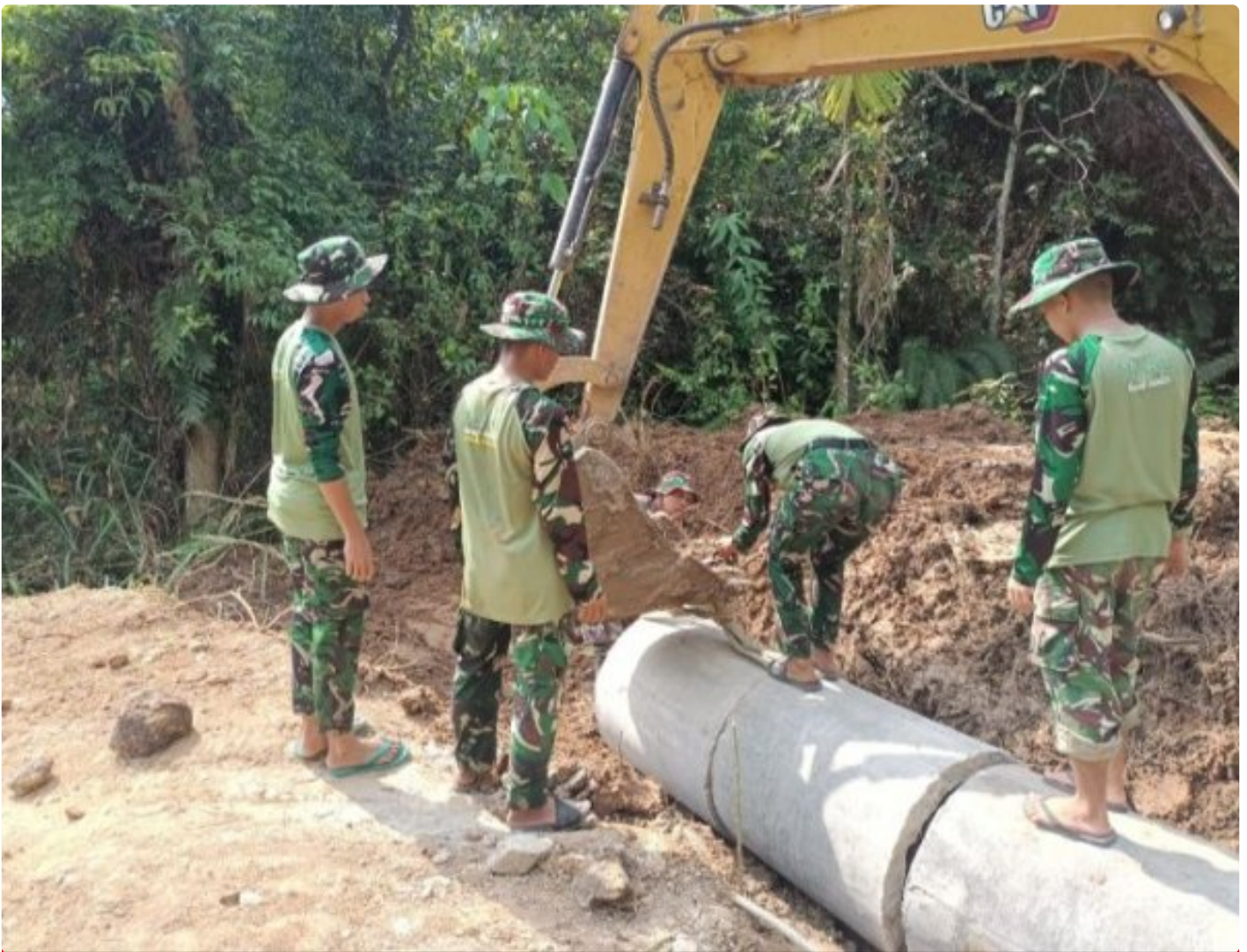
TMMD Agam Perkuat Infrastruktur: Gorong-gorong Dibangun di Nan Tujuh
